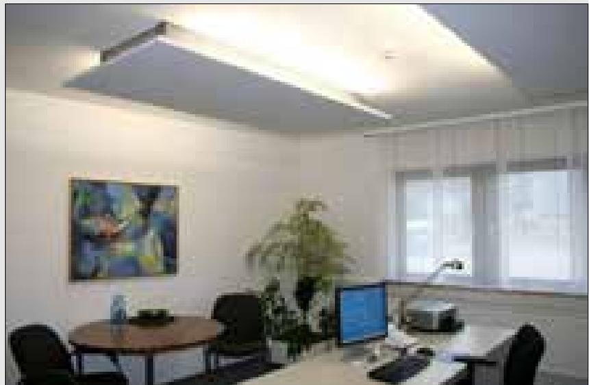
Mit einem Klimasegel an der Decke (Bild oben und unten rechts) oder seitlichen Klimawänden (Bild unten links) lässt sich das Raumklima individuell regulieren.
