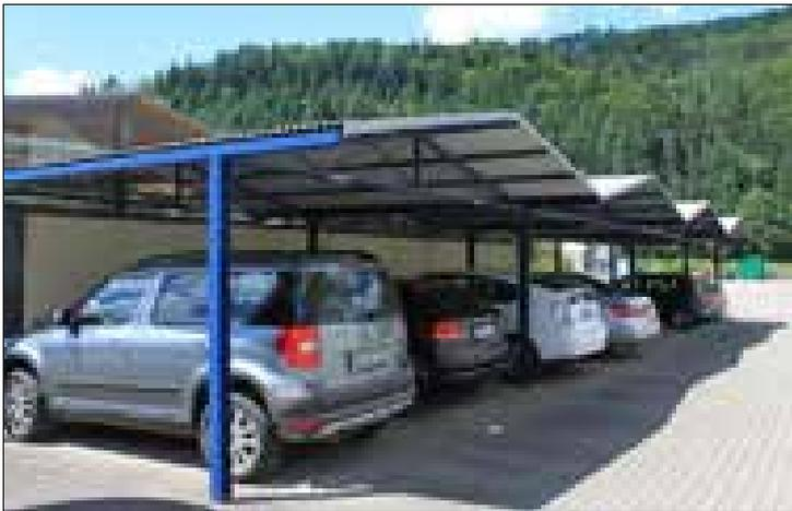
Überdachung für Fahrzeuge: Kienzler verbaut z.B. Quadrat- oder Rundrohre. Stahlteile werden feuerverzinkt und pulverbeschichtet – so entstehen langlebige Konstruktionen.
