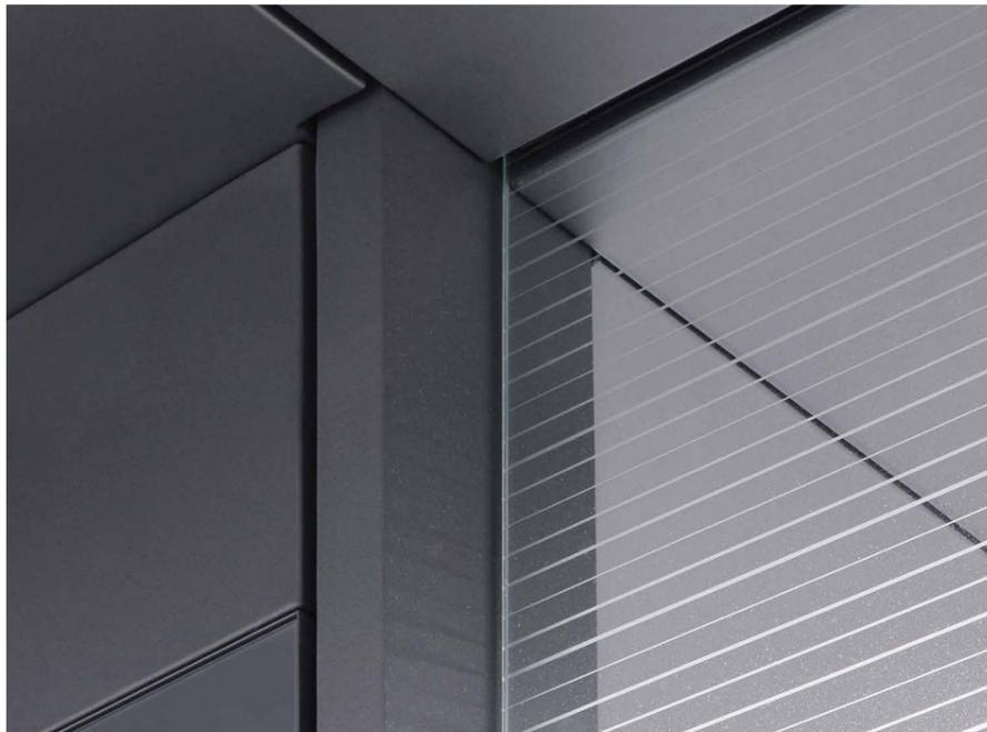
Schrauben? Bleiben unsichtbar. Die Befestigung der Glaselemente ist in die Profile integriert, deren Austausch dennoch einfach möglich. Es genügen dazu zwei Personen. Die Dachkassetten sind eingehängt.
