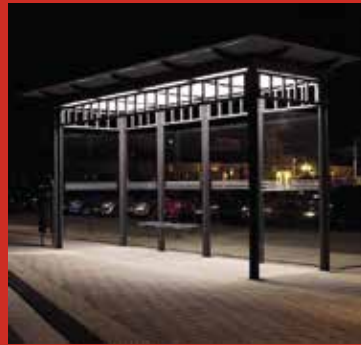
links: Mobilitätsstation, Offenburg rechts: ZOB, Wartehallen und Fahrradüberdachungen im gleichen Design, Bad Dürkheim
